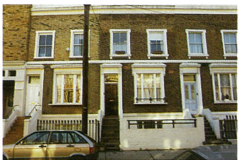
写真：04 WATERFORD RD.(W)(8)(05)
