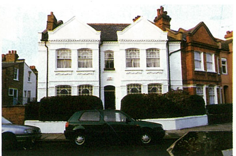
写真：24 OAKBURY RD.(N)(9)(06)端部の処理
