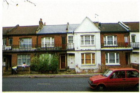
写真：18 WANDSWORTH BRIDGE RD.(E)(9)(05)リズム
